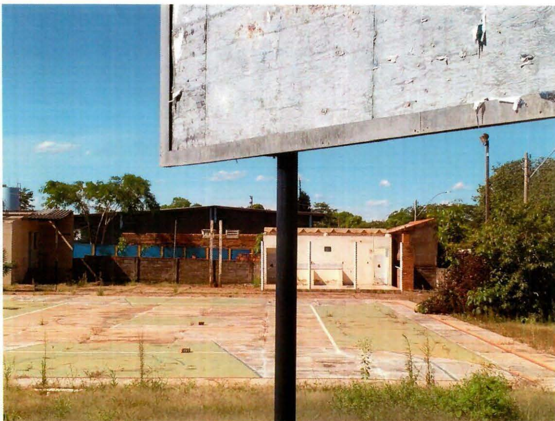
Vista pela Avenida Francisco das Chagas Oliveira
