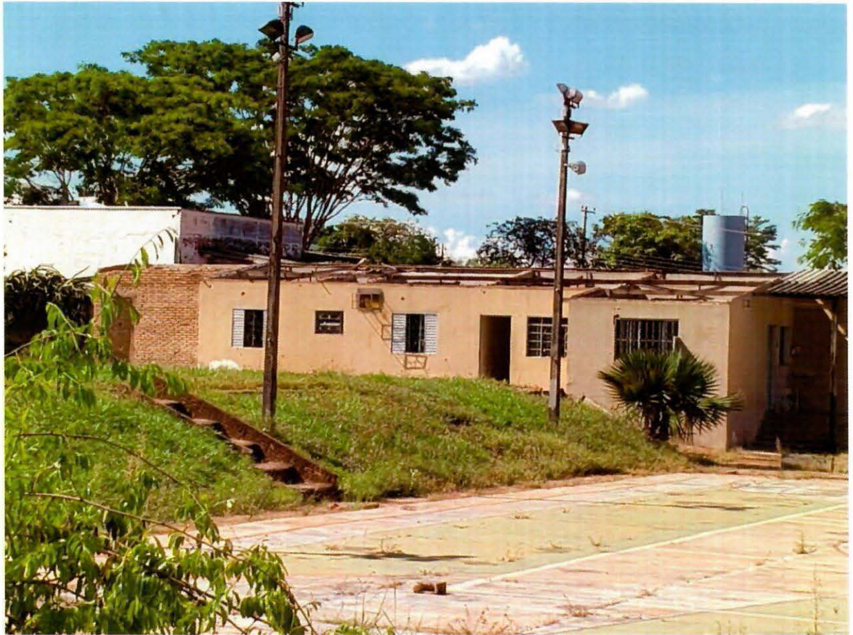
Vista pela Avenida Francisco das Chagas Oliveira
